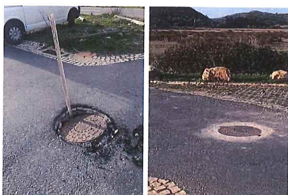
Boca do Rio - tampa
